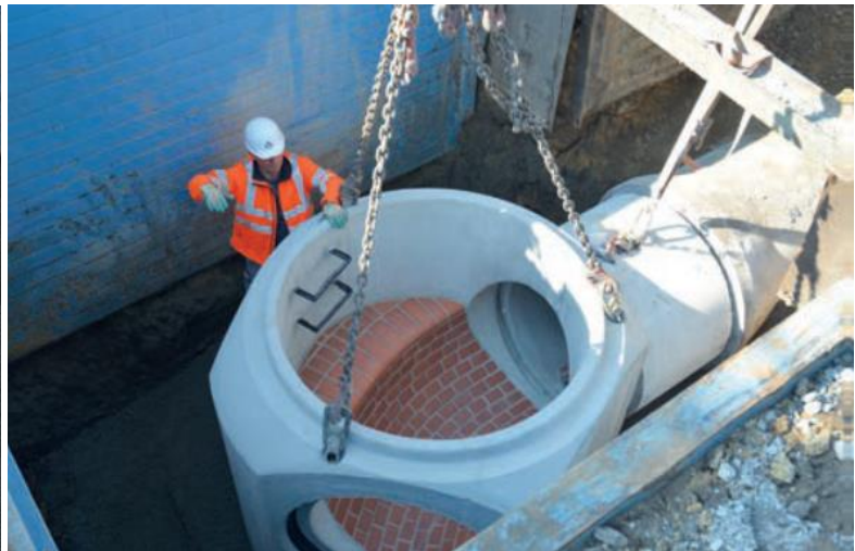
Exemple d'installation sur une surface propre et de niveau
