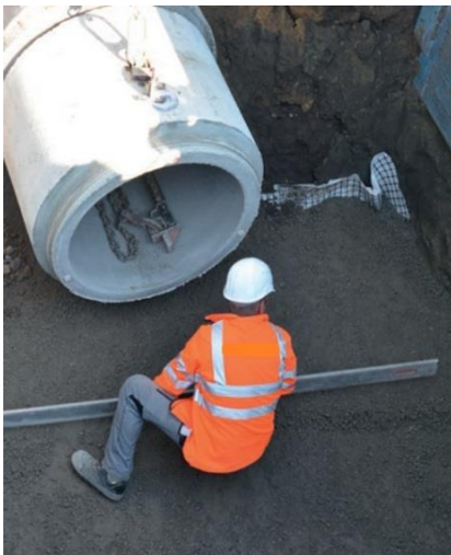
Exemple d'installation sur une surface propre et de niveau
