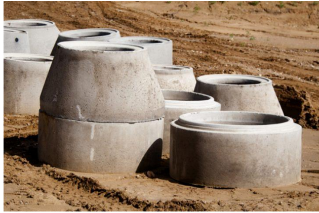
Beispiele für ordnungsgemäßes Abladen und Lagern auf der Baustelle
