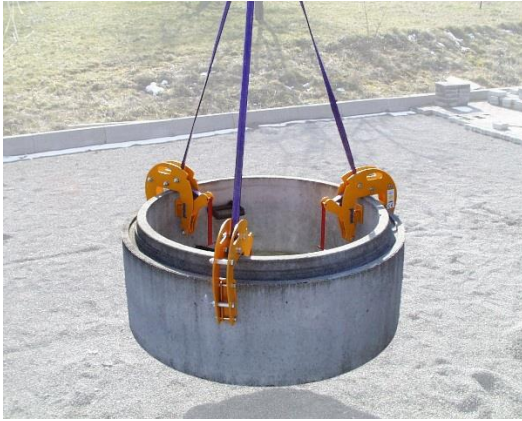
Beispiele für ordnungsgemäßes Abladen und Lagern auf der Baustelle
