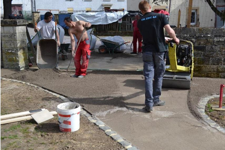
Verdichtung mittels geeigneter statischer Verdichtung (z.B. Walzen) ohne Rüttler
