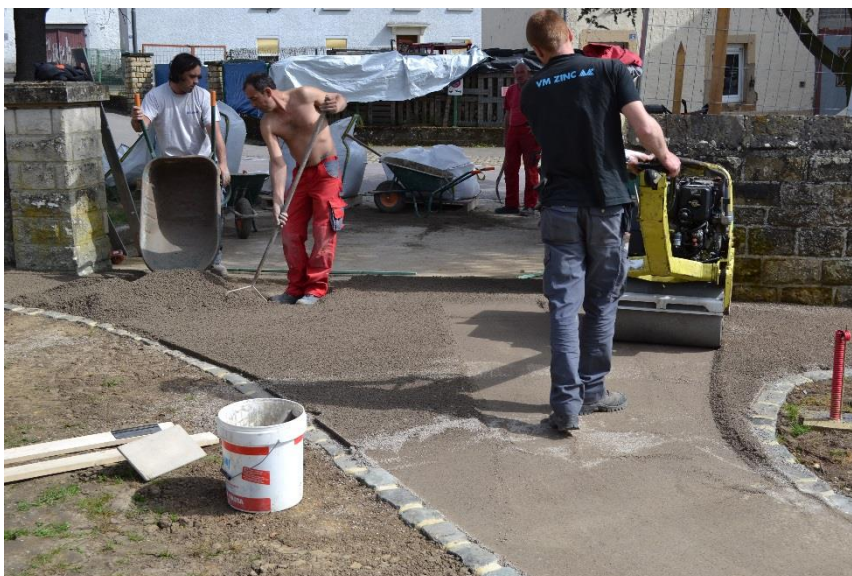
Compactage statique approprié sans vibrateurs.
