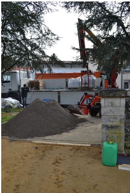
EcoParcLane déchargée au chantier
