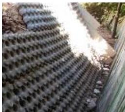
Besondere Aufmerksamkeit ist der Bettungsschicht bei der Verlegung in Böschungen zu widmen. Hier muss die Bettungsschicht aus drainierendem und festem Material bestehen. Durch das Verlegen eines Geotextils kann eine Erosion der Böschung verhindert werden. Bei starkem Gefälle empfiehlt sich die Verwendung von Bodenverankerungen.
