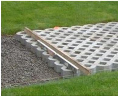
Um zu verhindern, dass das feine Material der Bettungsschicht durch die groben Steine dringt, was später zu Absenkungen führen kann, wird auf eine gute Stabilität zwischen diesen beiden Schichten geachtet; ggf. sind die Schichten durch ein Geotextil zu trennen.
